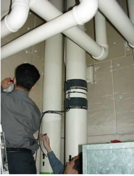
Kablo Sarım kurulumu
